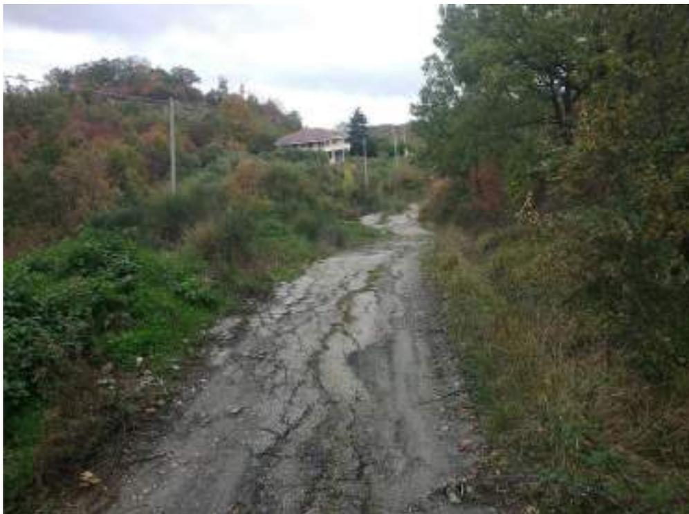
Foto 11– Il movimento di massa di figura 1 visto da valle con gravi danni all’infrastruttura stradale SP 11
