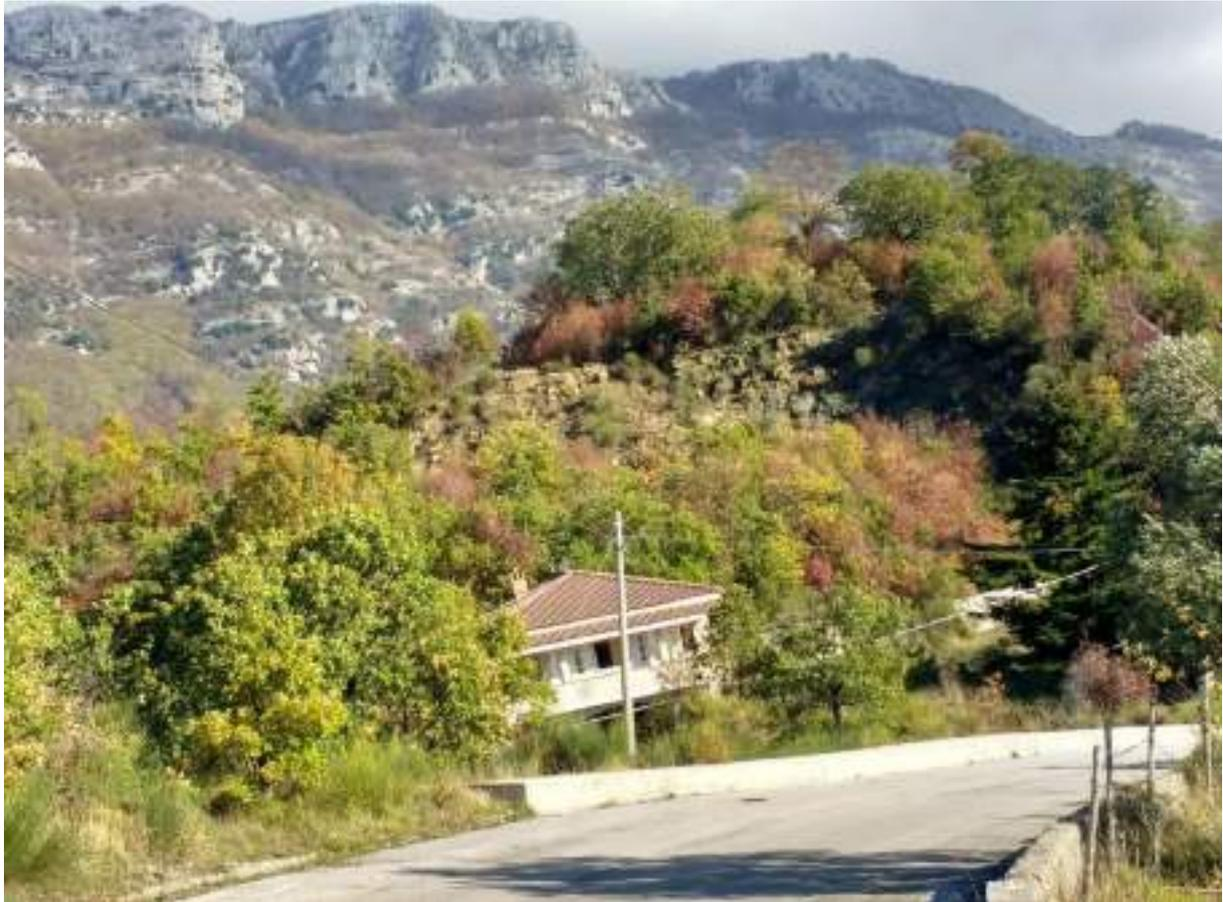
Foto 10 - Scorrimento rotazionale nelle Arenarie di Piaggine con gravi danni ad un fabbricato civile abitazione. Si nota la rotazione del fabbricato
